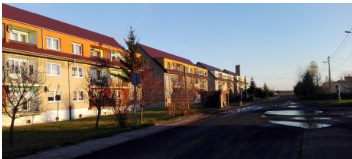
Zdjęcie 51. Zły stan drogi i chodnika w centrum wsi
