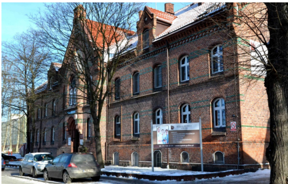
Zdjęcie 2. Niezagospodarowany i zaniedbany teren sąsiadujący z obiektami Szpitala Powiatowego w Gryfinie
