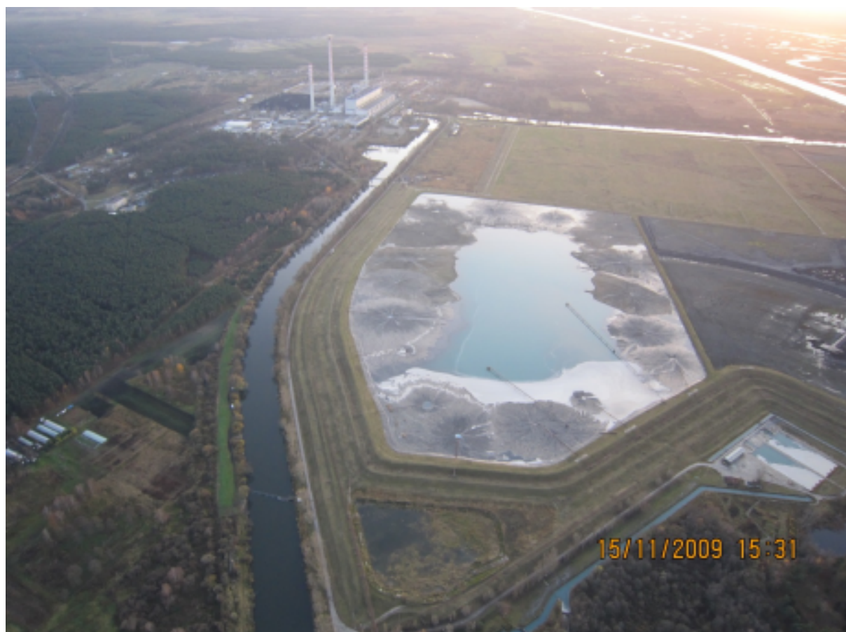
Zdjęcie 72. Kanał Ciepły przy Elektrowni Dolna Odra
