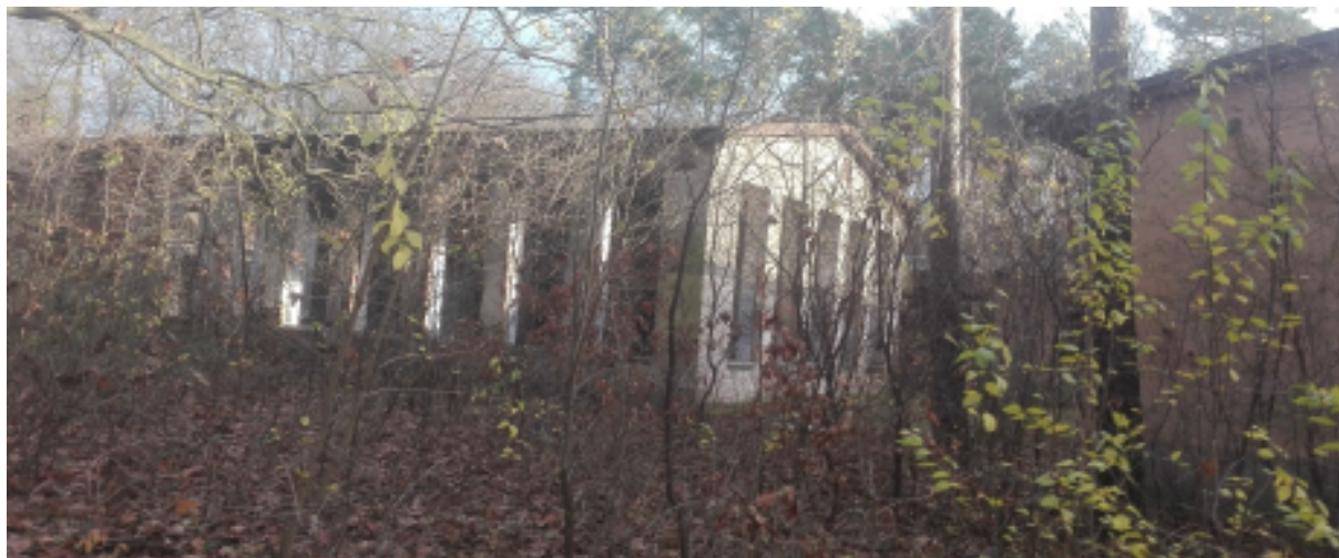
Zdjęcie 29. Opuszczone budynki po Sanatorium neuropsychiatrii dziecięcej, budynek basenu
