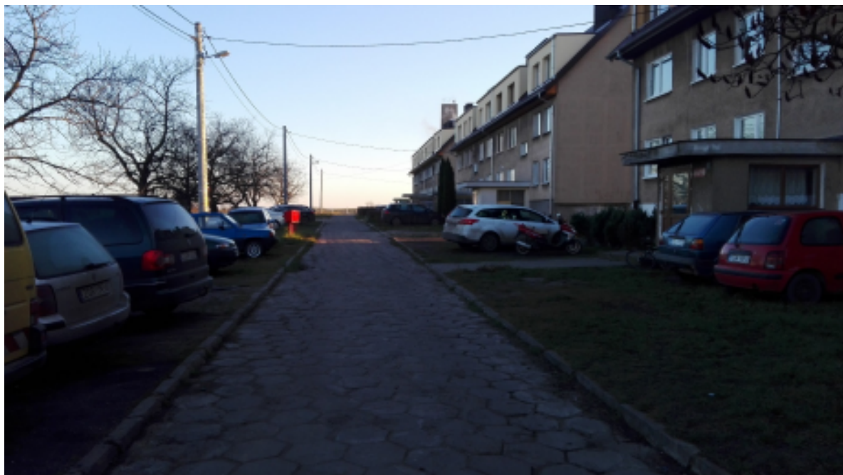
Zdjęcie 55. Parking oraz teren wspólny za blokami wielorodzinnymi (widoczna niska estetyka przestrzeni oraz zły stan chodników)
